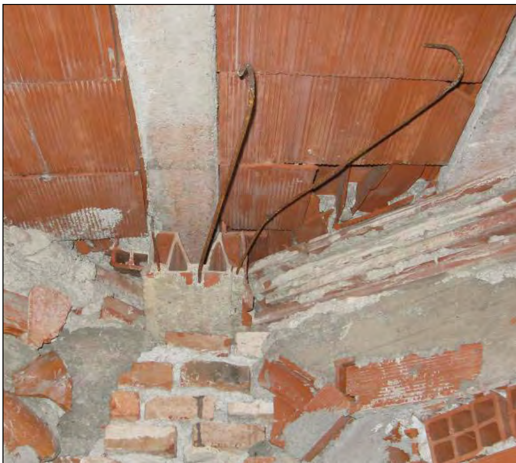
Figura 22: travetto tipo Sap in copertura con armature esposte
