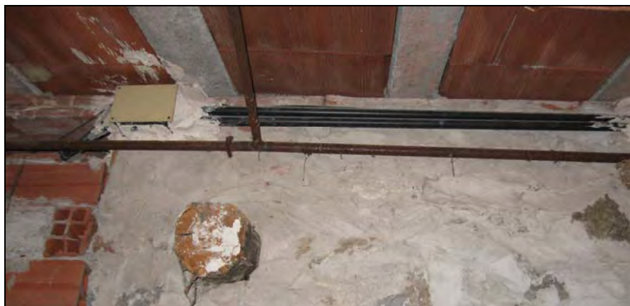
Figura 25: il moncone di una delle travi lignee della copertura originaria e il solaio di copertura attuale
