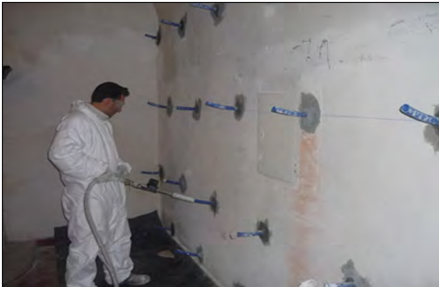
Figura 32: placcaggio di murature mediante sistema cam
