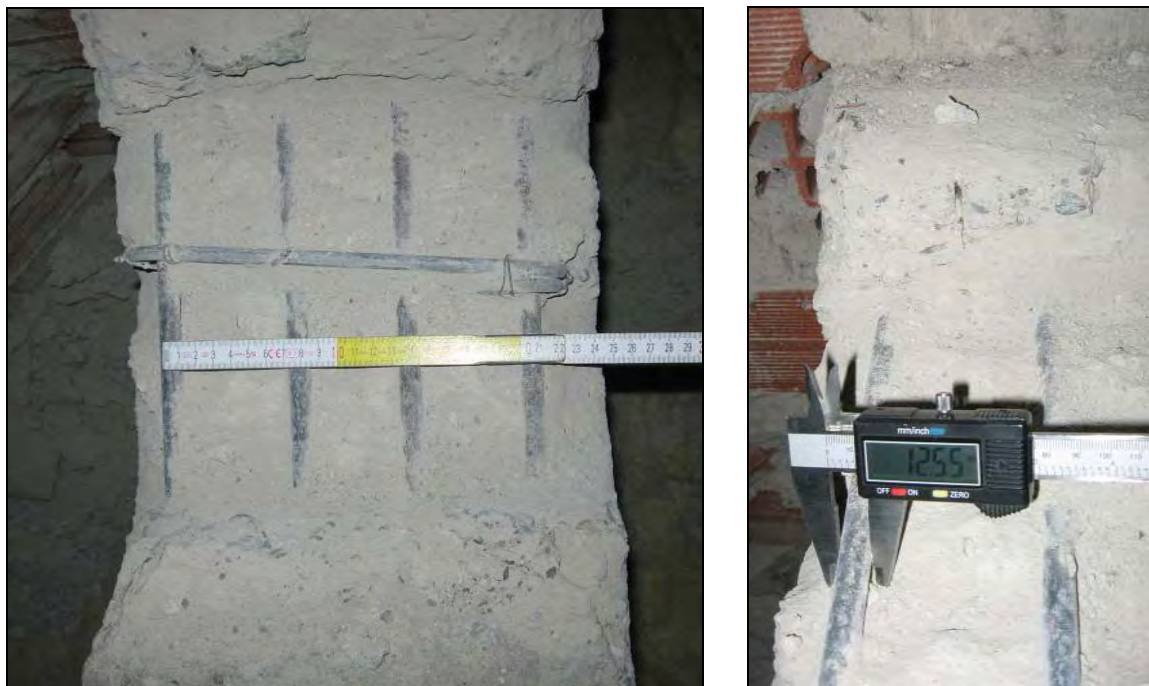
Figura 17: saggio mediante rimozione del copriferro e rilievo delle armature in soffitta
