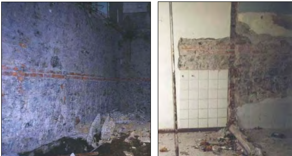
Figura 8: vista della tessitura della muratura originaria 1
