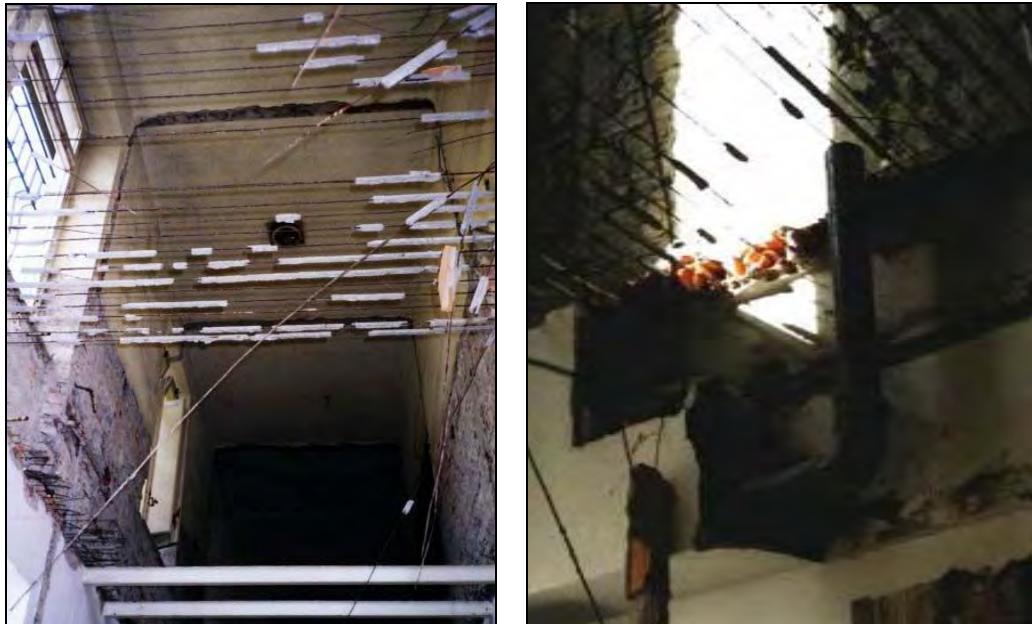
Figura 9: vista delle armature (sinistra) e della sezione (destra) del solaio originario Tipo 3 2
