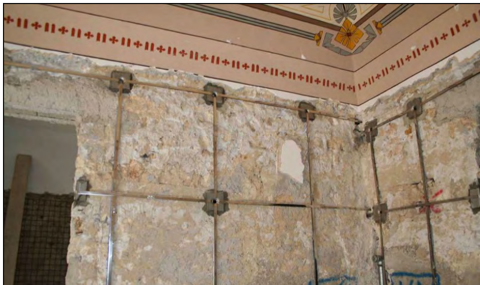
Figura 30: placcaggio di murature mediante sistema cam
