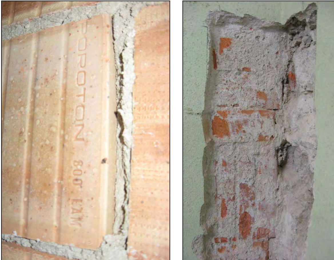
Figura 16: murature in blocchi Poroton – dettaglio (sinistra) e mancanza di ammorsamento (destra)
