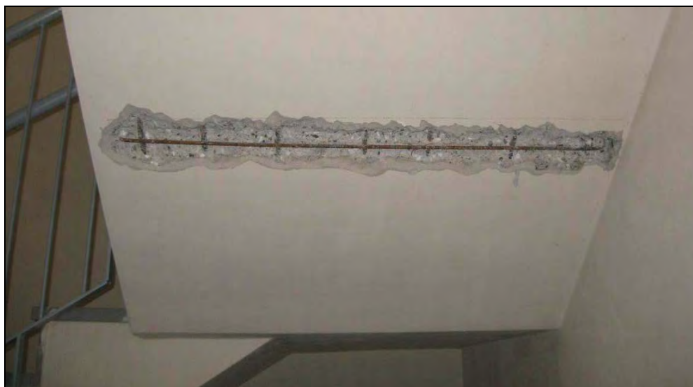
Figura 18: saggio sulle rampe delle scale mediante rimozione del copriferro
