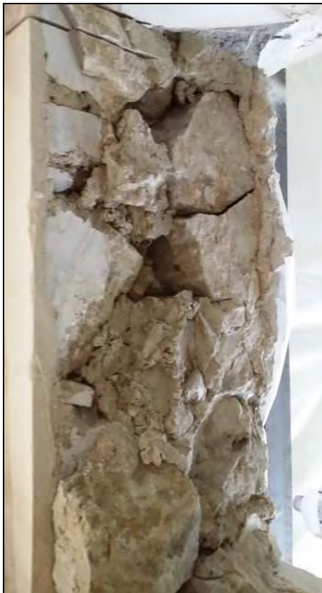
Figura 23: interno della muratura di pietrame
