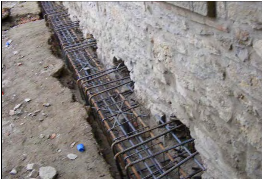
Figura 33: placcaggio di murature mediante sistema cam
