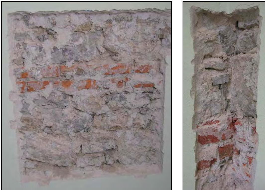
Figura 15: saggi sulle mura originarie – tessitura (sinistra) e ammorsamento (destra).
