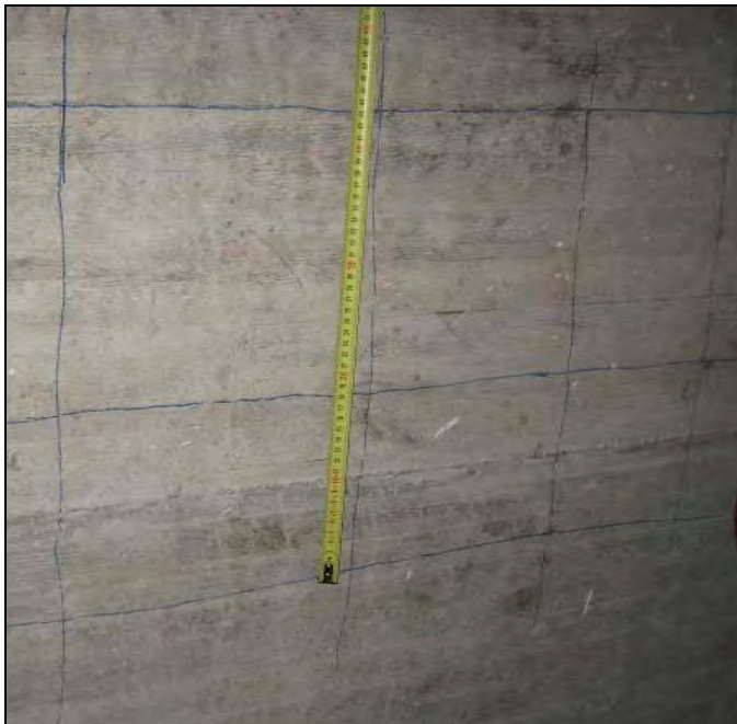
Figura 19: indagini e saggi sul nuovo muro di contenimento in c.a.
