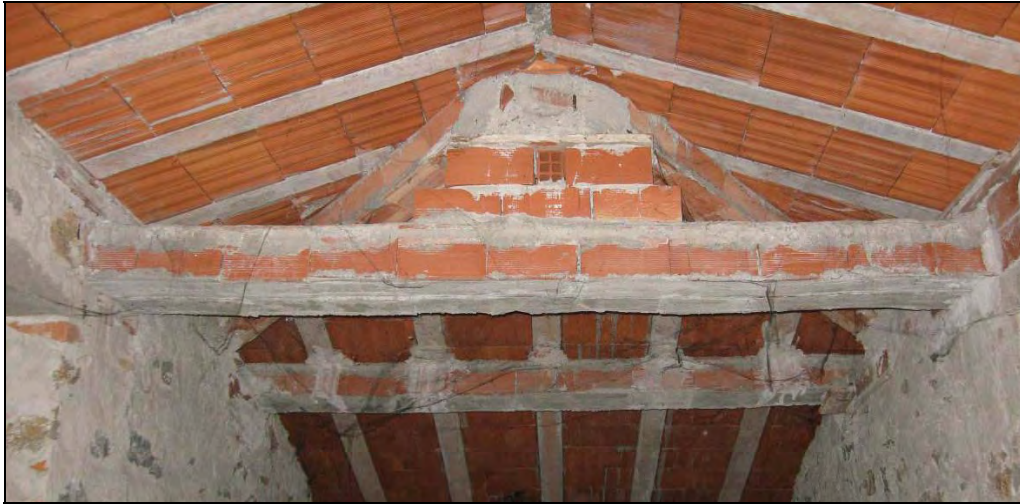
Figura 26: vista di una soluzione costruttiva non molto ortodossa adottata in copertura
