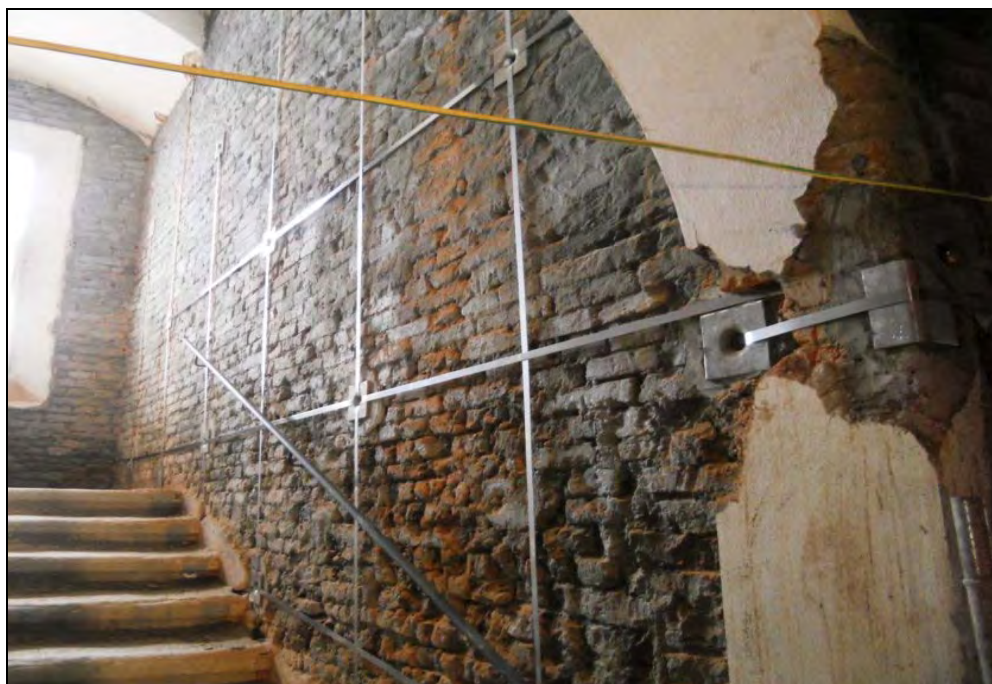
Figura 31: placcaggio di murature mediante sistema cam
