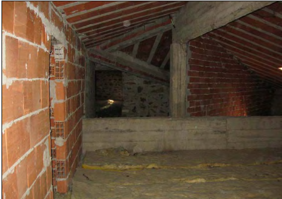
Figura 11: vista della soffitta, del solaio di copertura e dei suoi elementi portanti
