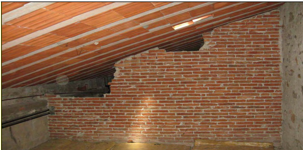
Figura 27: parete in muratura del piano soffitta non a contatto con il solaio di copertura
