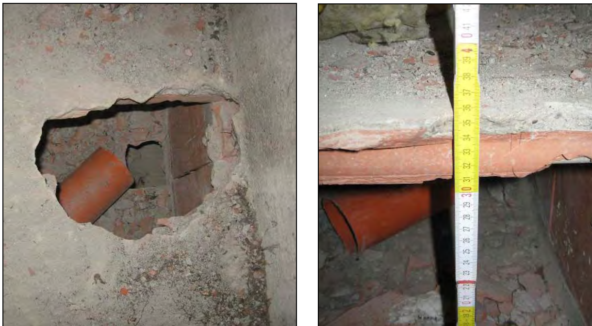
Figura 21: saggio sul solaio tipo 1 del piano soffitta
